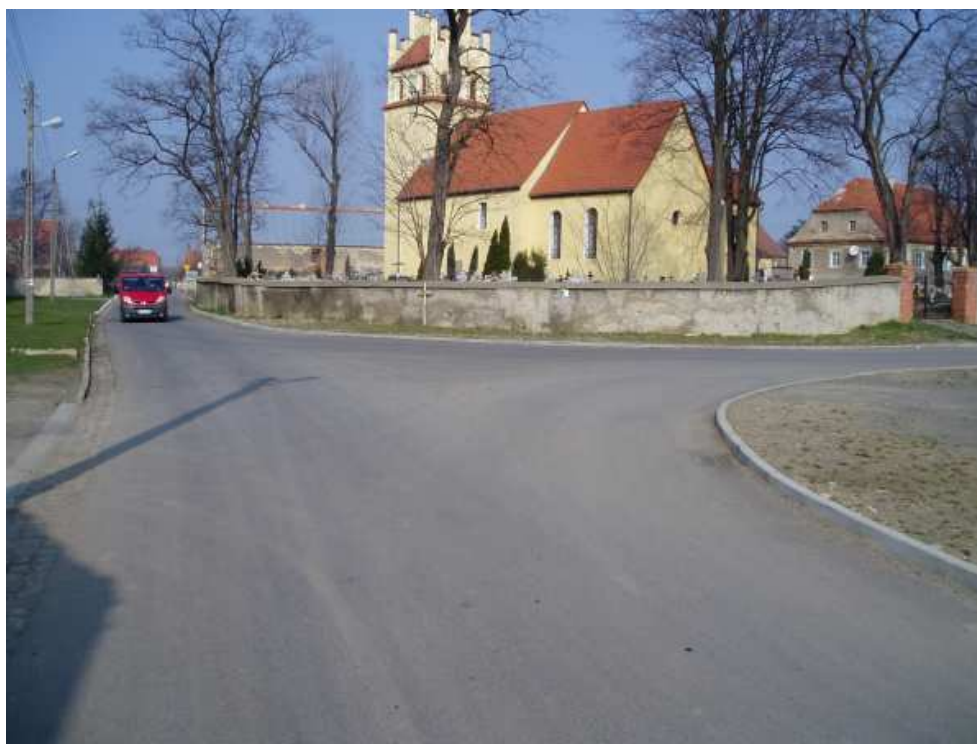
Remont drogi w Małuszowie
